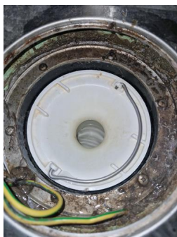
Tettesjiktets tilslutning til sluk - Sluk bad
