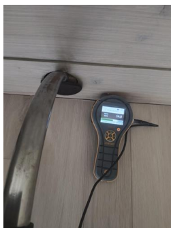
Utført kontroll i tilliggende konstruksjon - Fuktmåling
