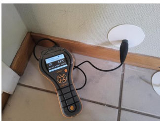
Utført kontroll i tilliggende konstruksjon - Fuktmåling
