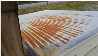
Tekking (med tilhørende beslag) - IMG_20260925_120030
