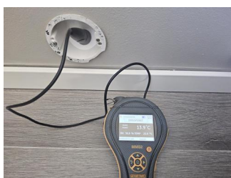
Utført kontroll i tiliggende konstruksjon - Fuktmåling.
