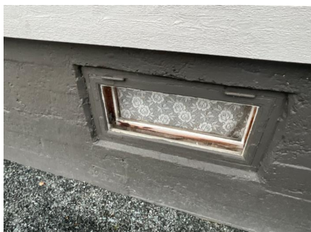
Vindu i kjeller med koblet glass
