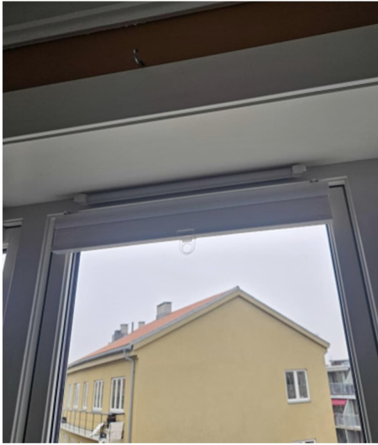
Bildet viser spalteventil i overkant av vindu.
