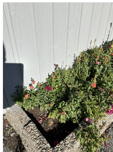
Bilde 4 · Yttervegger / fasade
