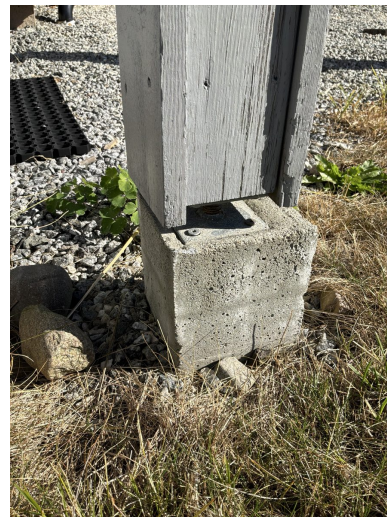
Bilde 11 · Balkonger / terrasser — fundamentering søyle
