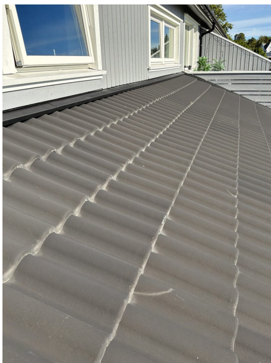
Bilde 8 · Taktekke og beslag
