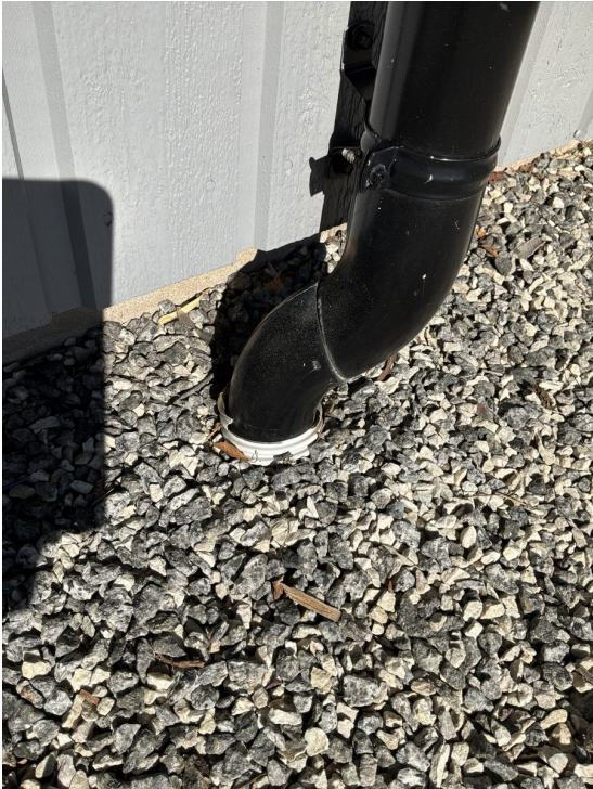
Bilde 1 • Fundament, grunnmur og drenering
