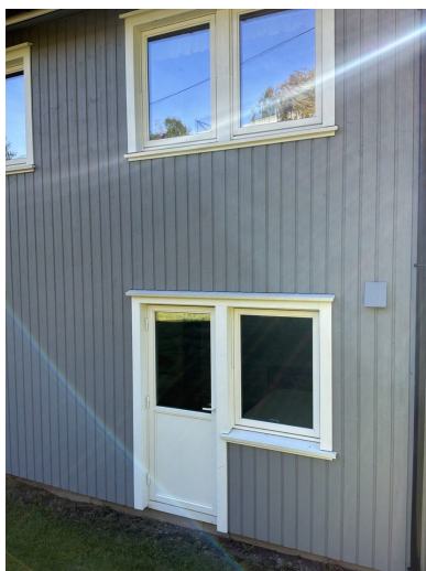
Bilde 3 · Yttervegger / fasade
