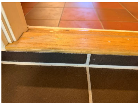
Overgang mot dørterskel.
