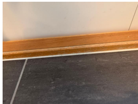
Overgang mot dørterskel.
