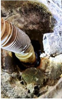
Tettesjiktets tilslutning til sluk - Sluk bad
