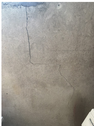
Bilde 1 · Fundament, grunnmur og drenering
