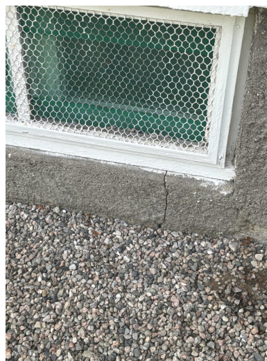
Bilde 3 · Fundament, grunnmur og drenering
