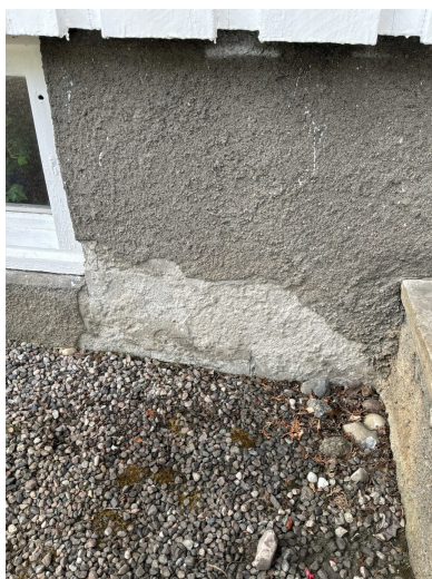
Bilde 2 · Fundament, grunnmur og drenering
