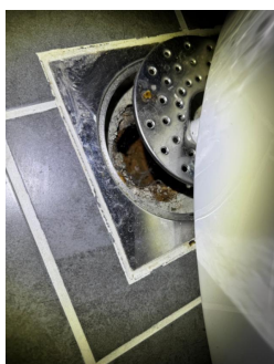
Sluk på badet der membran er smurt ned i sluk uten klemring
