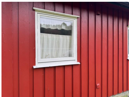
Vinduer med enkle glass fra byggeår
