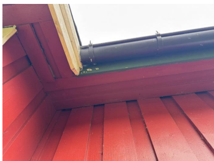
Begrenset ventilering av takkonstruksjon
