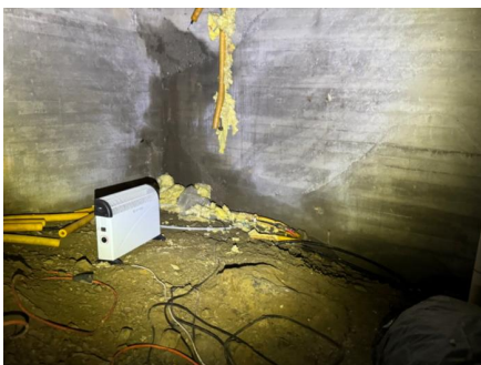
Fuktighet på grunnen og fukt i grunnmur mot jordkjeller/krypkjeller
