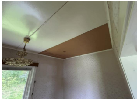
Himlingsplate byttet ut i stuen.
