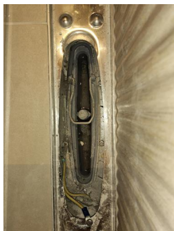
Tettesjiktets tilslutning til sluk - Sluk bad 1.etasje ved soverom
