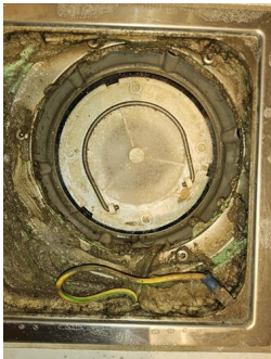
Tettesjiktets tilslutning til sluk - Sluk bad underetasje hoveddel
