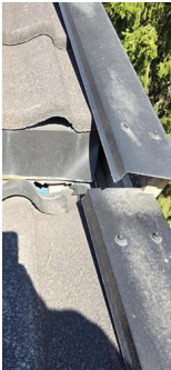
Detaljer inn mot tilstøtende konstruksjoner - Ødelagt/slitt beslag tak
