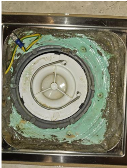
Tettesjiktets tilslutning til sluk - Sluk bad hybel
