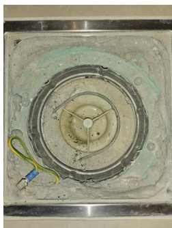
Tettesjiktets tilslutning til sluk - Sluk vaskerom
