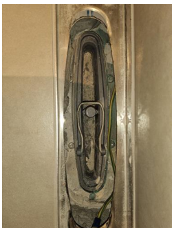
Tettesjiktets tilslutning til sluk - Sluk bad 1.etasje adkomst fra entré
