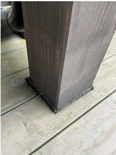
Bilde 7 · Balkonger / terrasser
