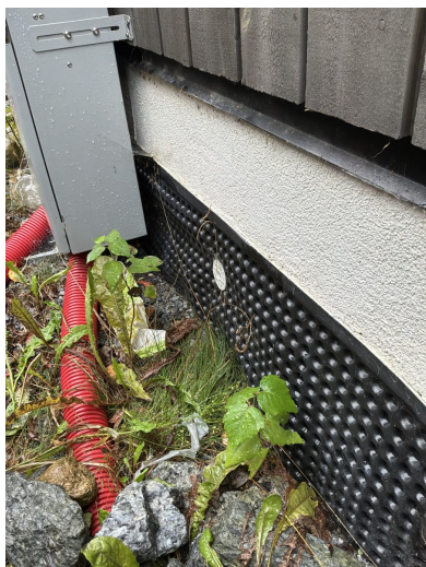
Bilde 1 · Fundament, grunnmur og drenering
