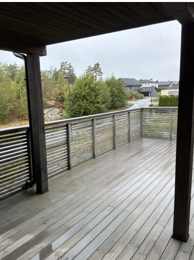
Bilde 6 · Balkonger / terrasser
