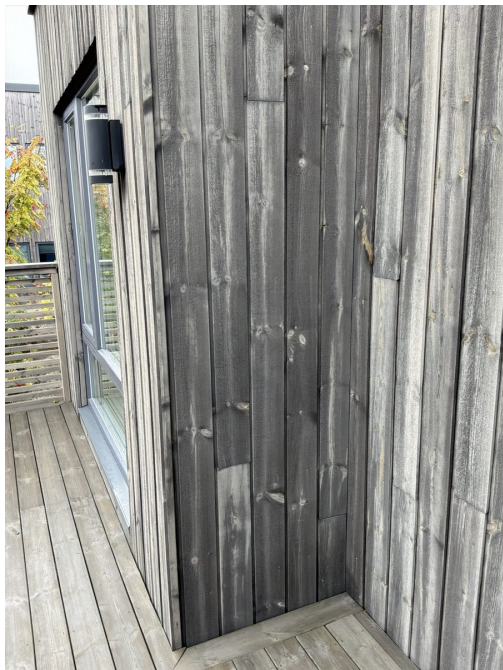
Bilde 4 · Yttervegger / fasade
