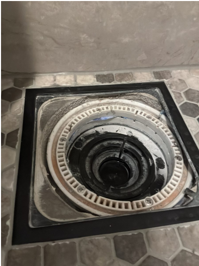
Bilde 11 • Dusjbad — Kjeller/u.etg
