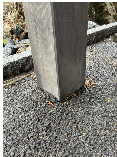
Bilde 3 · Fundament, grunnmur og drenering
