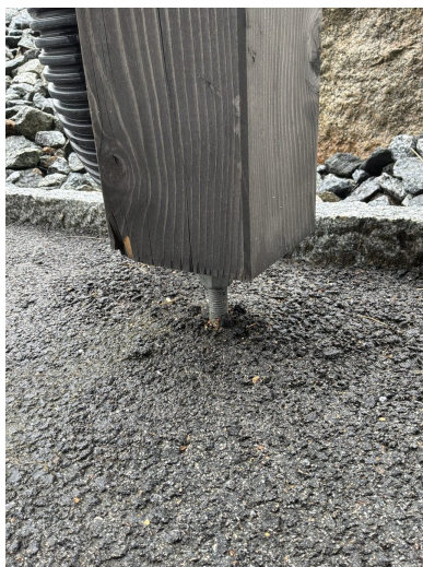
Bilde 2 · Fundament, grunnmur og drenering
