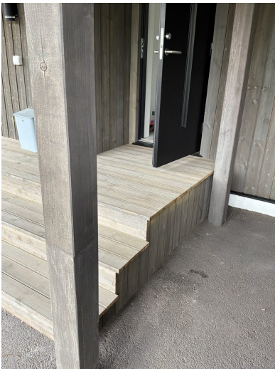
Bilde 8 · Balkonger / terrasser
