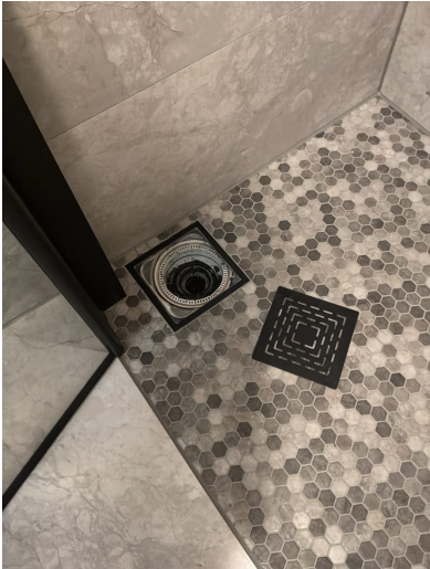
Bilde 12 · Dusjbad — Kjeller/u.etg
