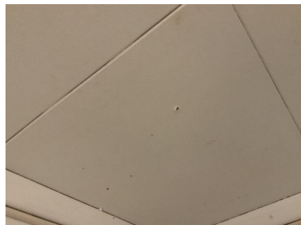
Hull og bruksmerker i himling.
