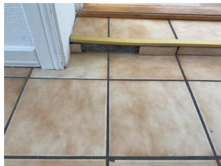
Mangler en flis på sokkel.
