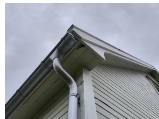
Overflatebehandling - Avflassing i raftkasse
