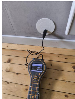
Utført kontroll i tilliggende konstruksjon - Fuktmåling
