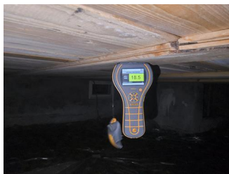
Stikktaking i treverk, fukt og fuktmålinger - Fuktmåling
