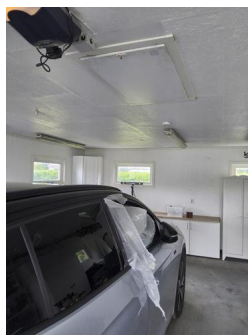
Innvendige forhold - Ingen adkomst til kaldtloft
