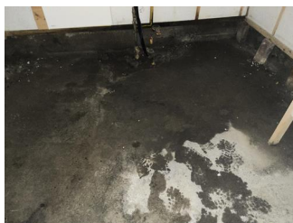
Kontroll i lukkede konstruksjoner ikke utført - Fukt pågulv
