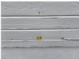
Ytterkledning (fasademateriale, vannbord, utvendig listverk, o.l.) - Rust på spiker
