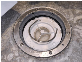
Tettesjiktets tilslutning til sluk - Sluk utenfor dusjsone
