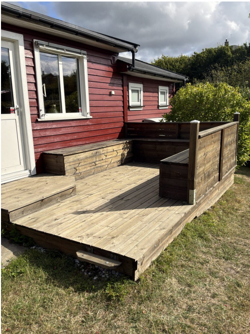
Bilde 3 • Balkonger / terrasser
