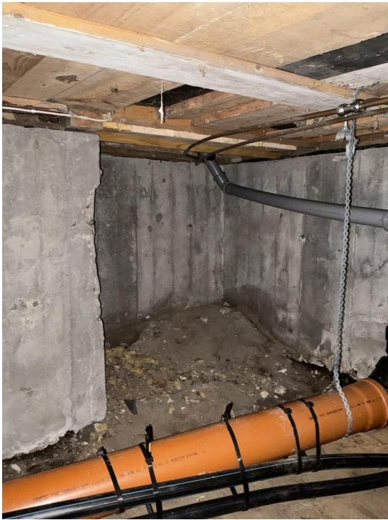
Bilde 1 - Fundament, grunnmur og drenering
