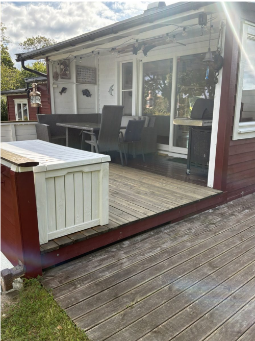
Bilde 4 • Balkonger / terrasser
