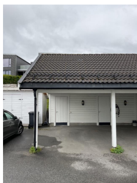
Egen car-port plass med tilhørende bod.
