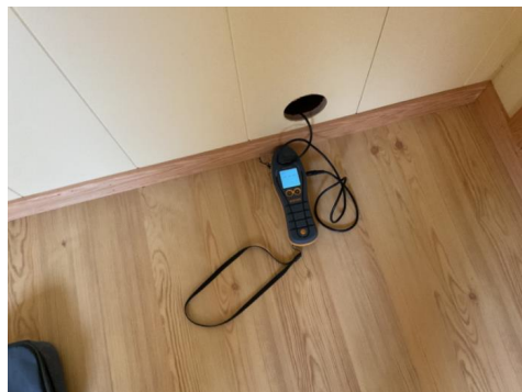
Fuktmåling i tillegg konstruksjon.
