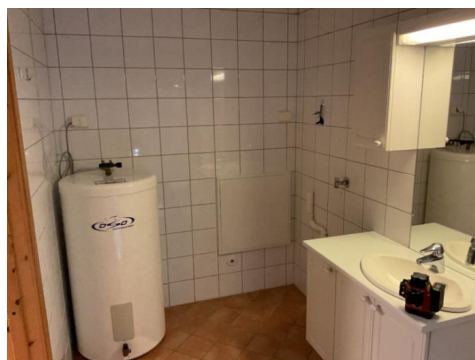
Oversiktsbilde av bad.
