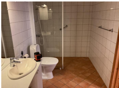
Oversiktsbilde av bad.
