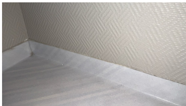
Eksempel utett overgang på tettesjikt i våtsone.
