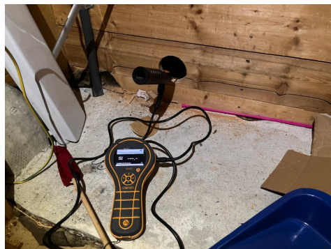
Eksempel hulltaking med fuktmåling med normale forhold.
