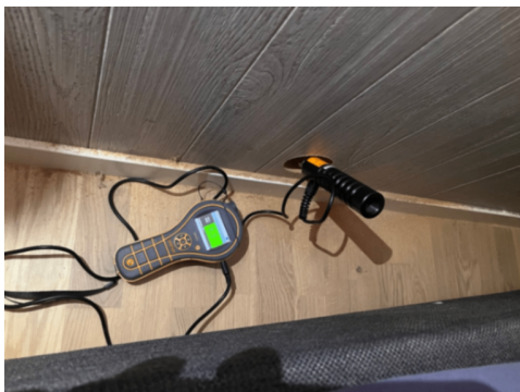
Eksempel hulltaking med fuktmåling med normale forhold.
