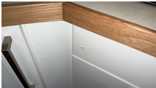
Eksempel skadet overflate.
