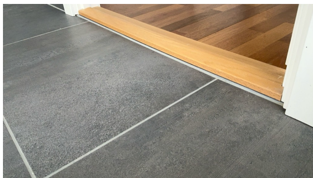
Eksempel vanntett oppkant ved dør ca. 5 mm.
