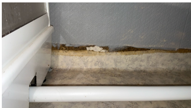
Eksempel utett overgang på tettesjikt i våtsone.
