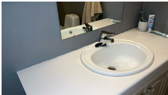
Eksempel uegnet materiale i våtsone.
