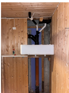
Innvendige avløpsrør med forgrening. Bilde tatt ved stakepunkt der rør i gulv ble skiftet fra.
