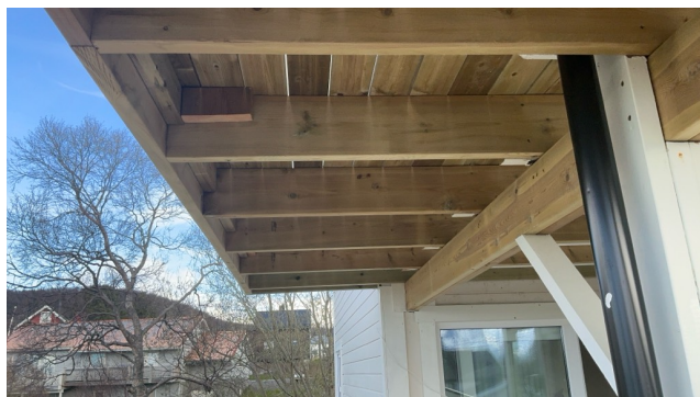
Eksempel for lang utkraging av bjelkelag.
