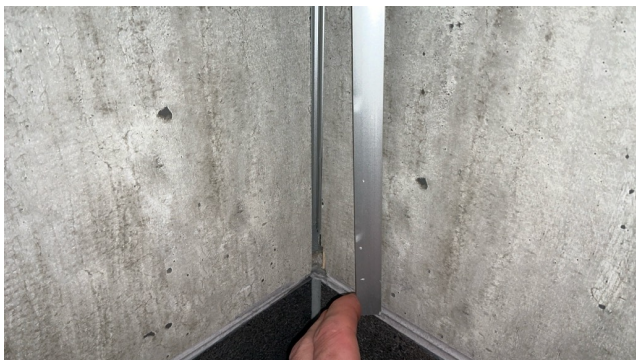
Eksempel ufagmessig montert hjørnelist.
