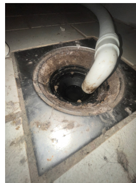
Eksempel sluk der membran ikke kan påvises.
