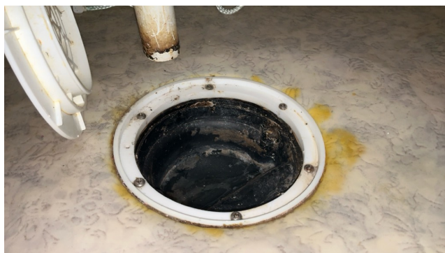
Eksempel eldre sluk og belegg.
