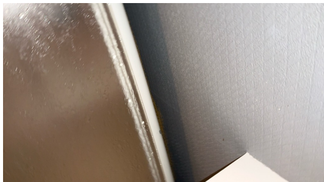
Eksempel uegnet materiale i våtsone.
