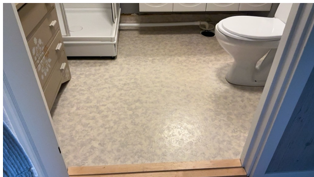
Eksempel overflate med lite fall.
