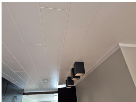
Tak og veggoverflater i kjøkken.
