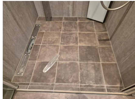
Flislagt gulv i dusjnisjen.
