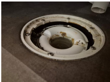
Våtromsbelegg er klemt til sluk.
