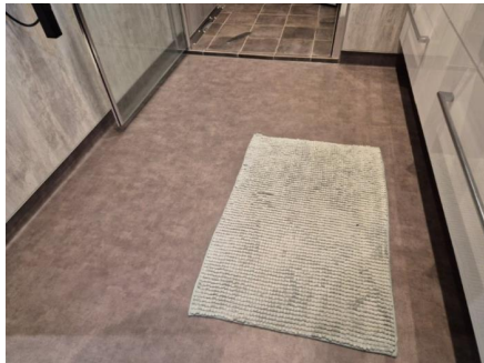
Baderomsgulv med sluk under servant, og slukrenne i dusjnisje.
