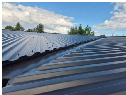
Gradrenne på yttertak.
