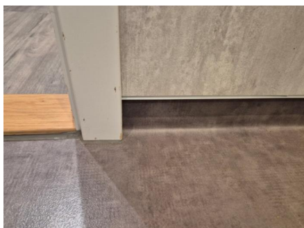
Baderomspanel med sokkellist.
