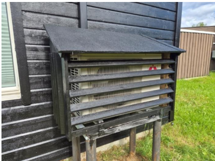
Utedel til luft til luft varmepumpe.
