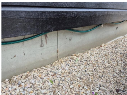
Fibersementplate (Steni-plate) er montert mot utvendig mur.
