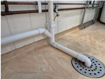
Avløpsrør i vaskerom.
