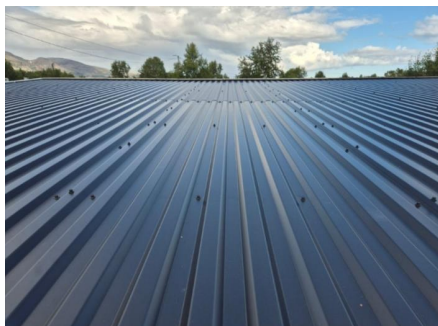
Taket er tekket med stål/aluminiumsplater.
