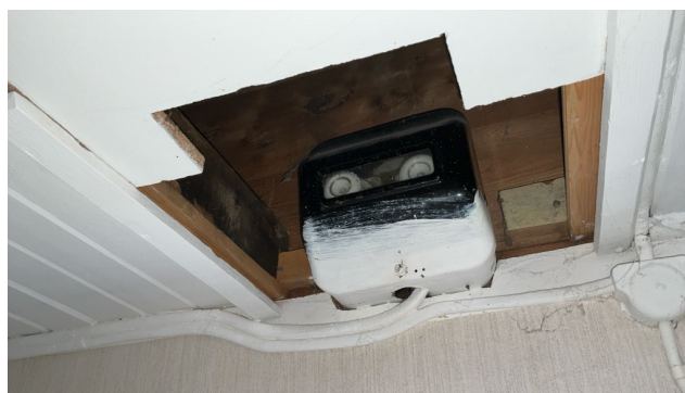
Inntakssikring ved loftsluke.
