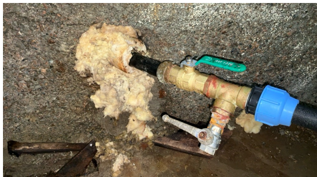
Eksempel vanninntak med stoppekran.
