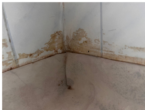
Eksempel utett utførelse av belegg.
