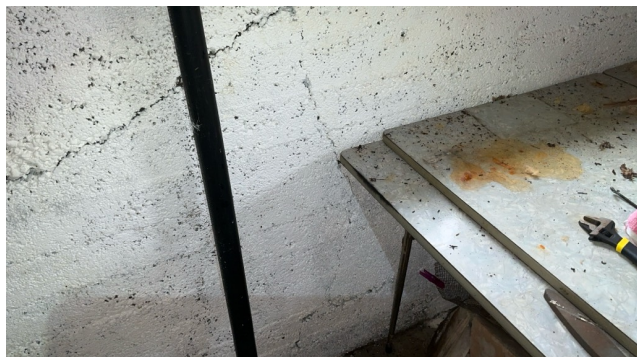
Eksempel sprekk/riss.
