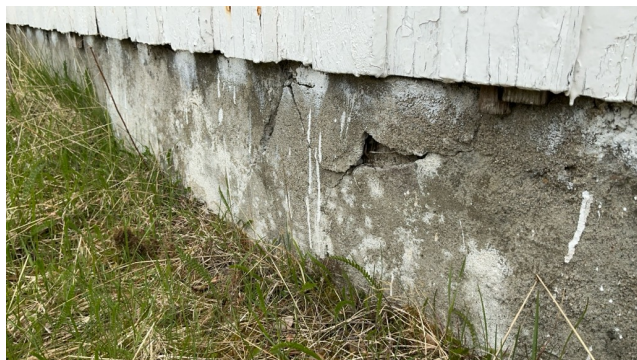
Eksempel grunnmurskader.
