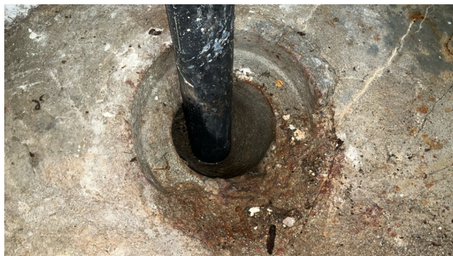
Eksempel eldre betongsluk.
