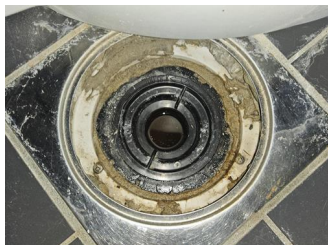
Vanntett sjikt / membran i gulv og vegger - Sluk vaskerom
