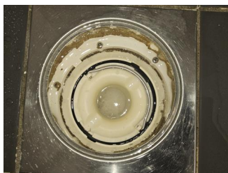
Vanntett sjikt / membran i gulv og vegger - Sluk bad
