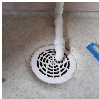
Avløp (inkl. sluk) - Sluk i gulv
