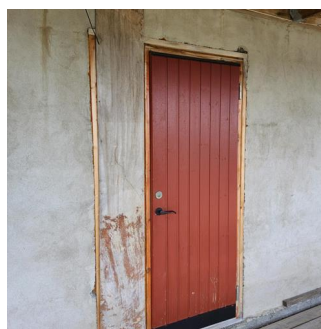
Ytterdører og omramming - Eksempel på gjenstående arbeider kjellerdør
