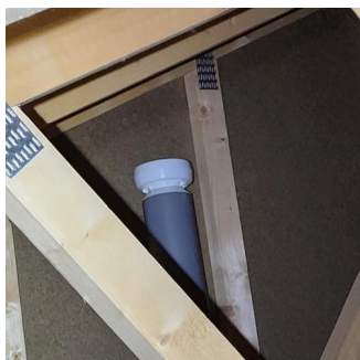
Avløprør (utover det som nevnes under andre sjekkpunkter) - Lufteventil avløpsrør på loft
