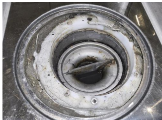
Tettesjiktets tilslutning til sluk - Sluk utenfor dusj
