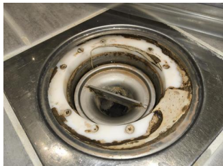
Tettesjiktets tilslutning til sluk - Sluk i dusj
