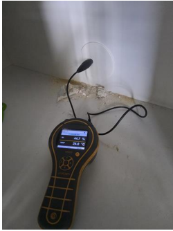
Utført kontroll i tilliggende konstruksjon - Fuktmåling
