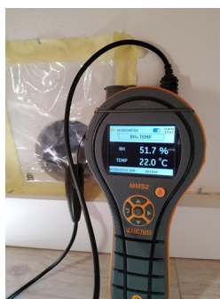
Utført kontroll i tilliggende konstruksjon - Fuktmåling bad.
