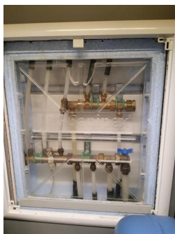
Vannrør (utover det som nevnes under andre sjekkpunkter) - Fordelerskap
