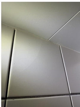
Sprekt flis i øverste rad mot himling innenfor dusjvegger.
