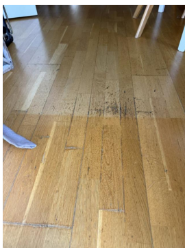
Bruks slitasje og forskjell i pigmentering i parkettgulvet.
