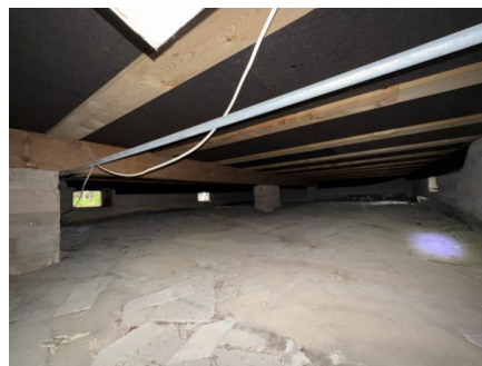
Krypkjeller under tilbygd stue.
