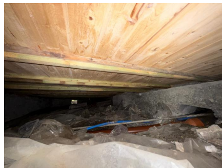
Krypkjeller under kjellerstue/soverom.
