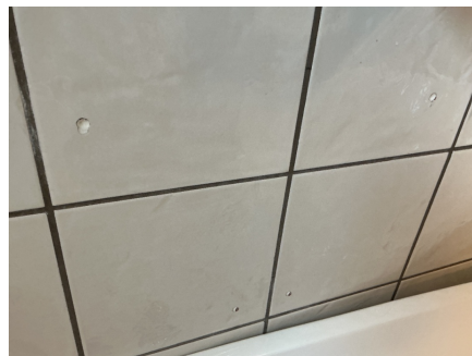
Provisorisk tetting av hull i fliser
