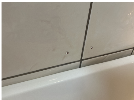
Provisorisk tetting av hull i fliser
