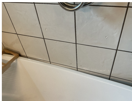
Provisorisk tetting av hull i fliser
