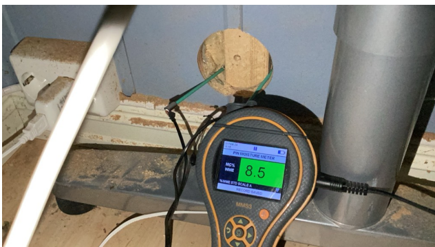
Ingen fuktighet påvist.
