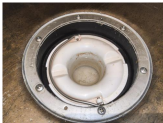
Tettesjiktets tilslutning til sluk - Sluk
