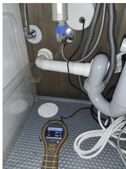
Utført kontroll i tiliggende konstruksjon - Fuktmåling
