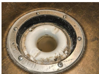
Tettesjiktets tilslutning til sluk - Sluk ved innredning
