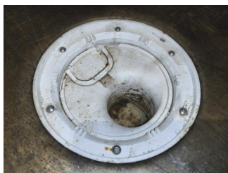
Tettesjiktets tilslutning til sluk - Sluk ved varmtvannsbereder
