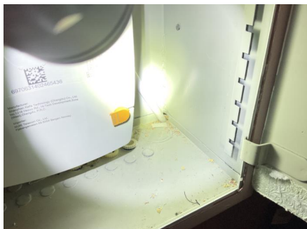
Utett gjennomføring.
