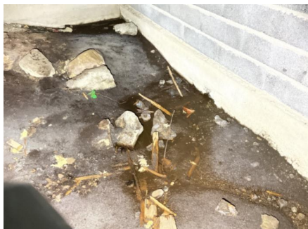
Eksempel på synlig vann i krypkjeller.
