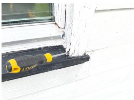
Eksempel på anløp til råteskader.
