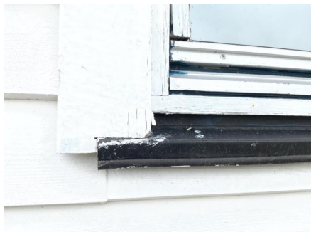
Eksempel på manglende åpning mellom beslag og kledning.
