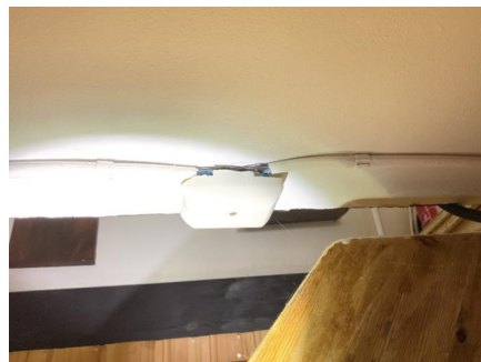
Ufagmessig utførelse av det elektriske anlegget.
