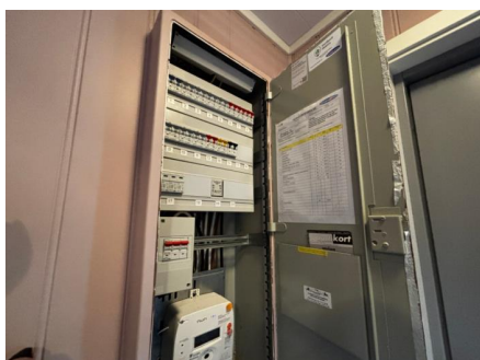
Utett gjennomføring.
