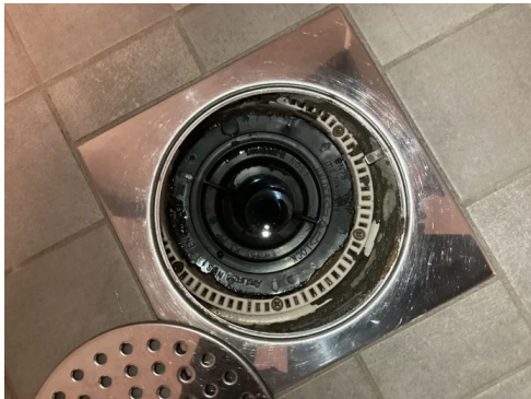
Bilde av sluk i dusjsone.
