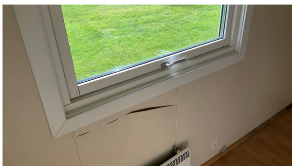
Skader på overflater på vegg.
