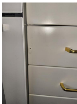
Innredning - Skade i skuff
