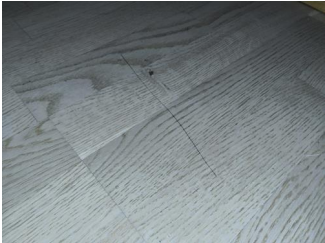
Overflate gulv - Ripe i stuegulv
