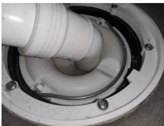
Tettesjiktets tilslutning til sluk - Sluk
