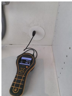
Utført kontroll i tiliggende konstruksjon - Fuktmåling
