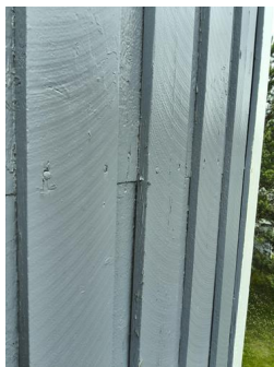
Overflatebehandling - Slitt overflatebehandling
