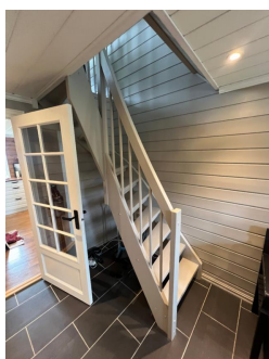
Rekkverket på den ene siden øverst i trappen virker noe ustabil/løst.
