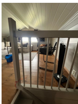
Rekkverket på den ene siden øverst i trappen virker noe ustabil/løst.
