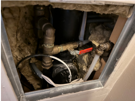
Stoppekran bak luke i vindfang
