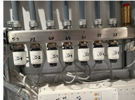
vannbårent varmeanlegg
