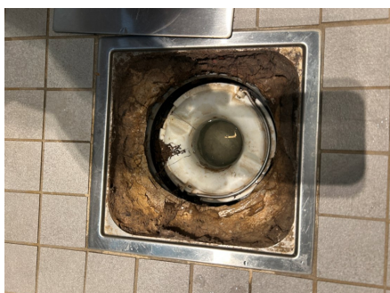
sluk, membran og tettesjikt
