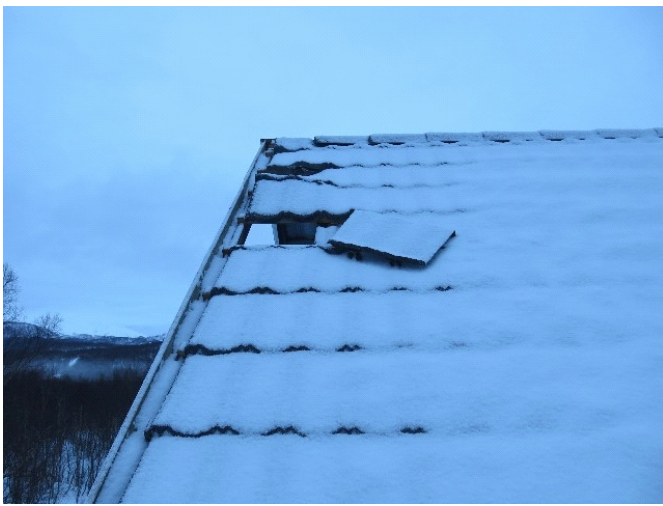
Dekkbord, decra-plater og mønepanner er revet.
