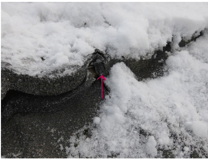
Her er det brukt vanlig galvanisert håndspiker, ikke originale decra-spiker eller -skruer
