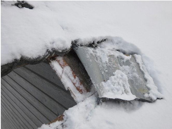
Undertaket er kontrollert, og funnet uskadet
