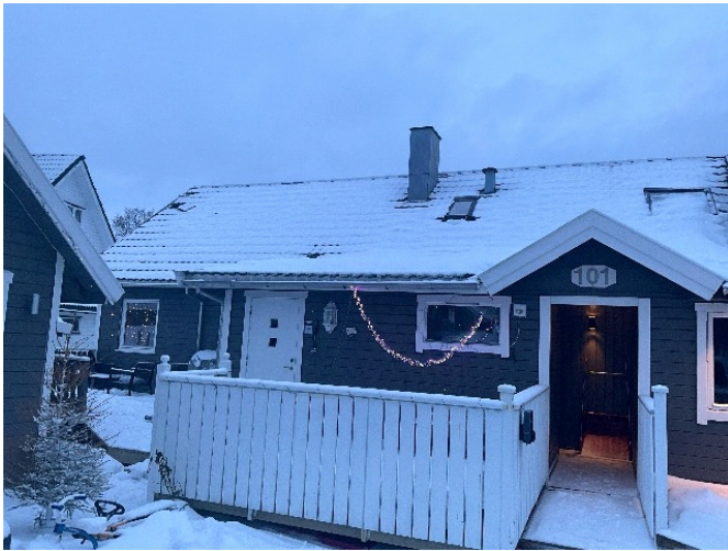
Bjørndalslia 101, fasade og tak-side mot vest.
