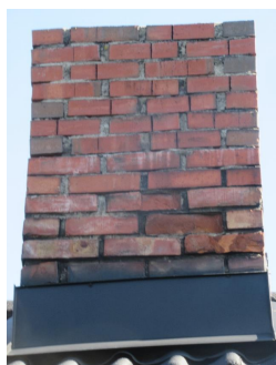
Pipe i opprinnelige del av boligen
