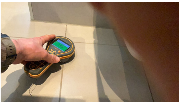
Fuktsøk viste normale verdier.
