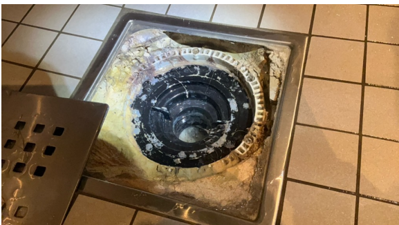
Kontroll av sluk.
