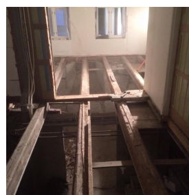
Gulv og leire fjernet i 1. etasje.
