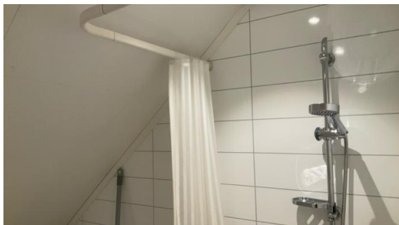
Skråhimling over dusj.
