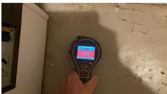
Fuktmåling indikerer fuktvandring og fuktopptrekk via kjellervegg.
