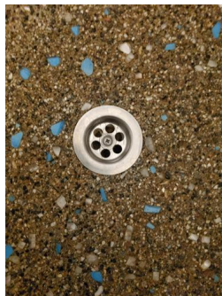
Tettesjiktets tilslutning til sluk - Sluk i dusjsonen.
