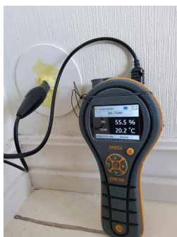
Utført kontroll i tilliggende konstruksjon - Fuktmåling bad.
