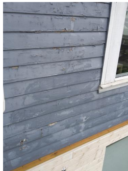
Ytterkledning (fasademateriale, vannbord, utvendig listverk, o.l.) - Fasaden
