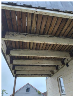
Konstruksjon og fundamenter - Underside
