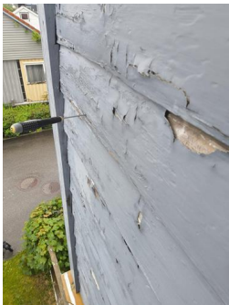
Ytterkledning (fasademateriale, vannbord, utvendig listverk, o.l.) - Ytterkledningen
