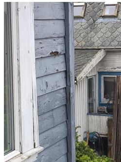
Ytterkledning (fasademateriale, vannbord, utvendig listverk, o.l.) - Fasaden
