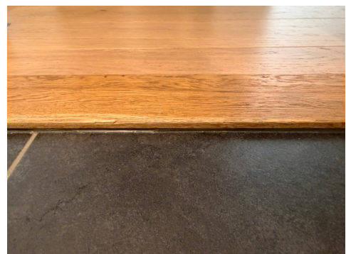
Overgang mot dørterskel.
