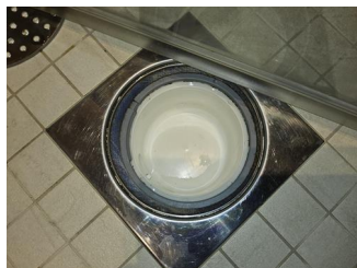
Tettesjiktets tilslutning til sluk - Sluk, bad.
