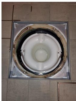
Tettesjiktets tilslutning til sluk - Sluk dusj bad
