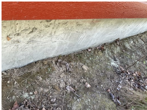
Konstruksjon med gulv på grunn.
