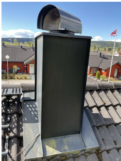
Helbeslått pipeløp over tak
