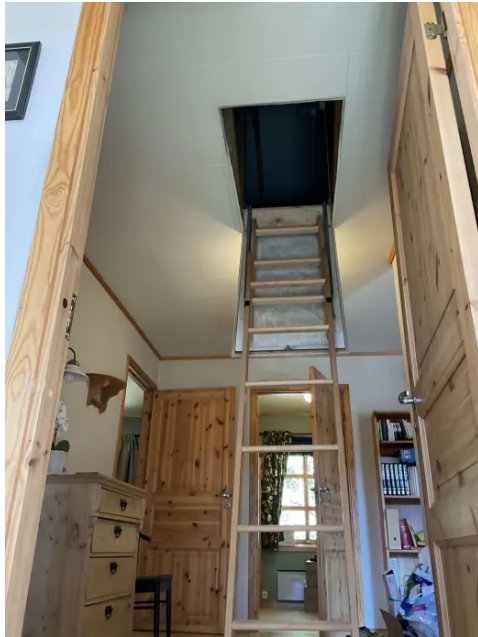
Adkomst til kaldtloftet via himlingsluke i gang
