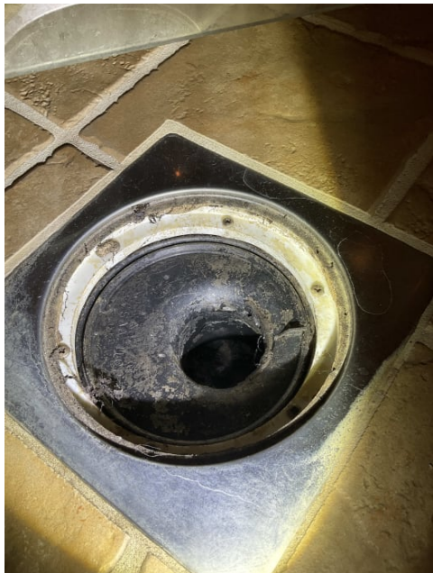
PVC-sluk med stakemuligheter
