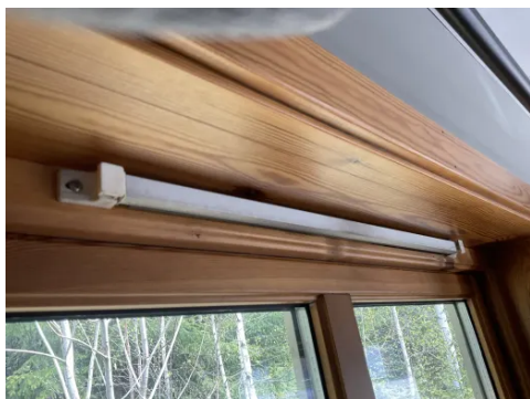
Bolig med naturlig ventilasjon via luftespalte i øvre del av karm
