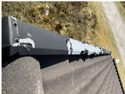
Isbordbeslag med avflassing og slipp i foliering
