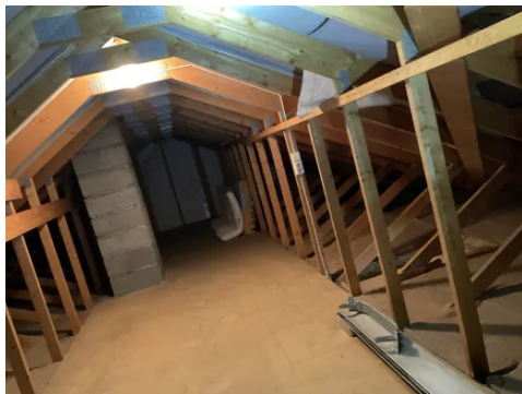
Takkonstruksjon utført med pre-fabrikkerte taksperrer
