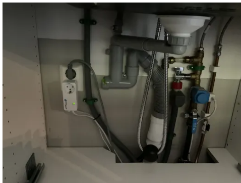
Synlige innvendige avløpsrør i PVC-plast
