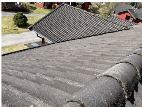
Tekkingen er vurdert oppe på taket
