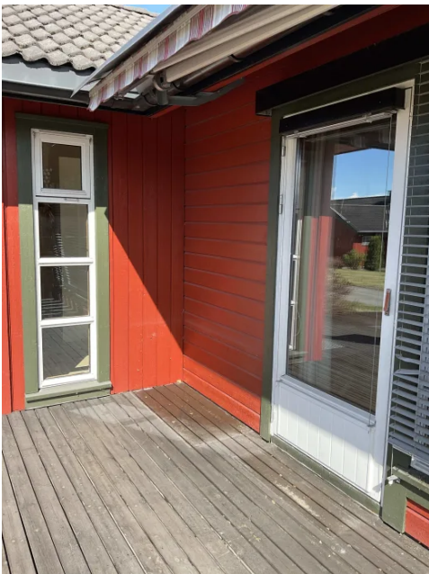
Malt terrassedør med isolerglass
